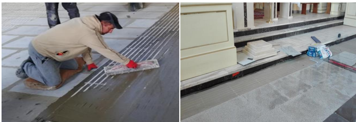
Aanbrengen onder gehele tegelvloer
