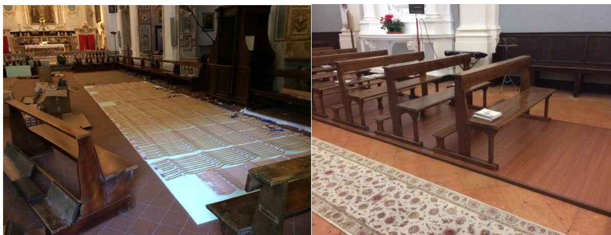
Lokaal aanbrengen onder kerkbanken afgewerkt met een laminaatvloer
