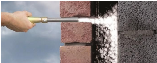
Figuur: Gespoten spouwmuur-isolatie
