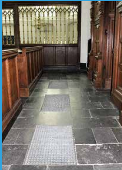
Verwarmingsplaten in de vloer. Vloerverwarmingsroosters
