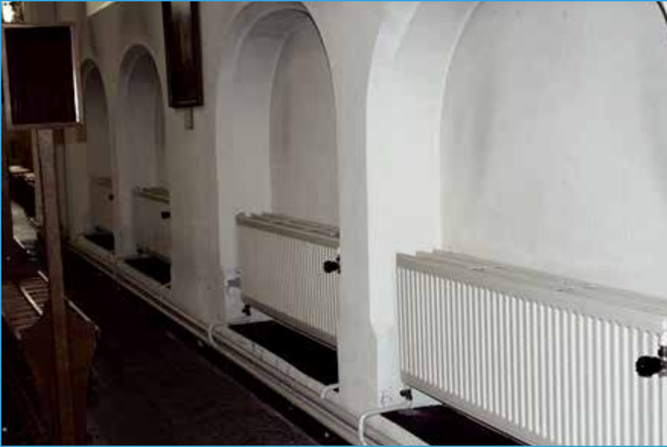
Radiatoren zijn alleen voor kleinere kerken geschikt als verwarming.
