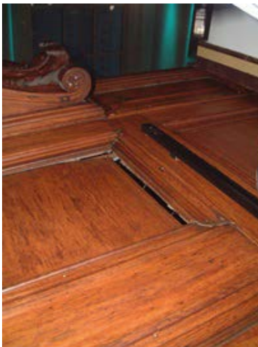
Gekrompen panelen (bron: Flentrop)
