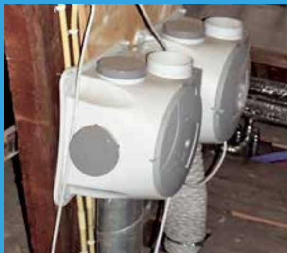
Mechanische afzuigunits.
