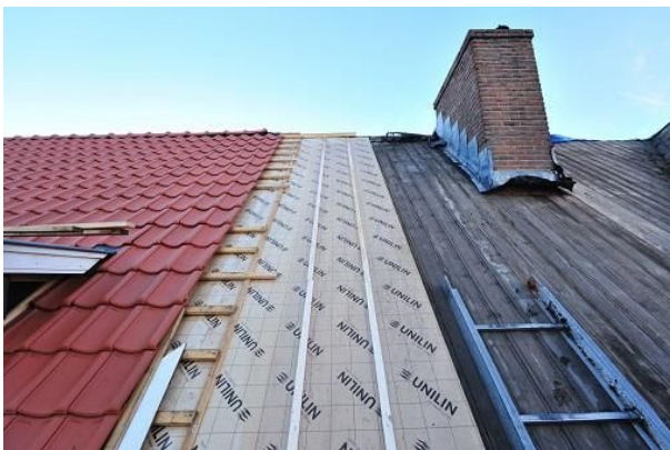
Figuur: Na-isolatie hellend dak met renovatieplaten
